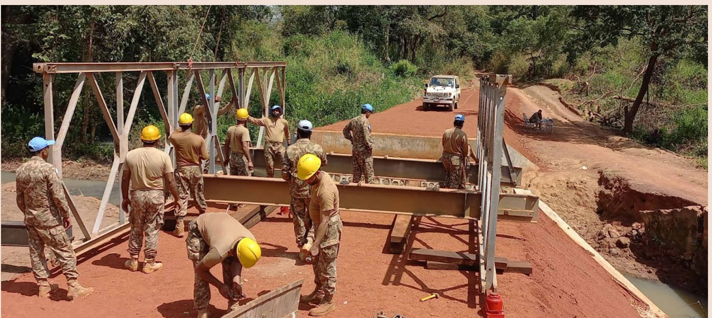
Une équipe du génie civil du contingent pakistanais de la MINUSCA réhabilitant un pont métallique de l'axe Kaga-Bandoro – Azène, le 28 novembre 2022. Les différents contingents de la Force MINUSCA contribuent à la réhabilitation et construction de ponts essentiels pour faciliter la libre circulation et la protection des civils. Photo MINUSCA
