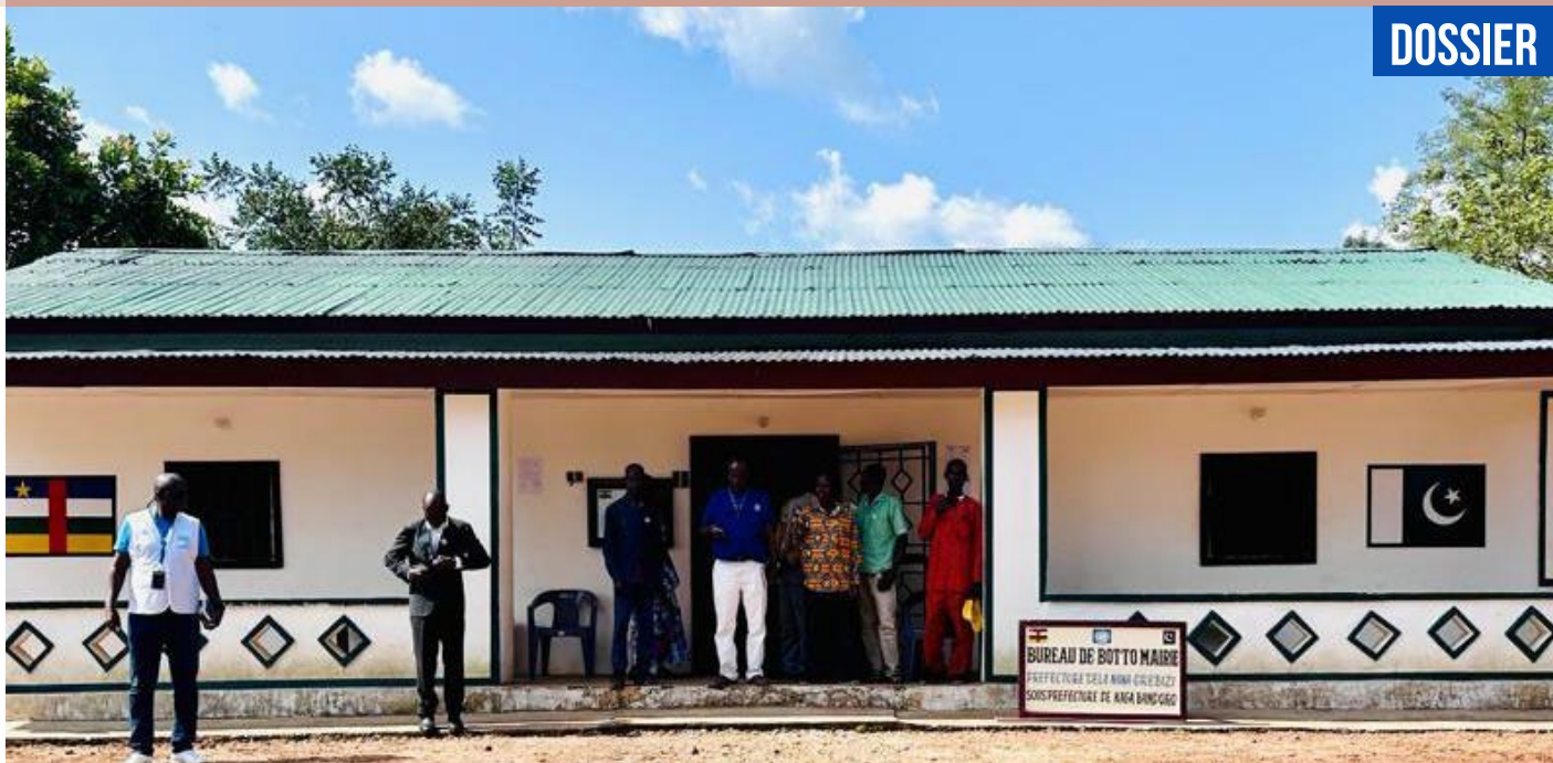
La Mairie de Botto. Un bâtiment moderne construit et équipé par le contingent pakistanais, dans le cadre des projets à impact rapide. Photo MINUSCA/Abdourahmane Diallo
