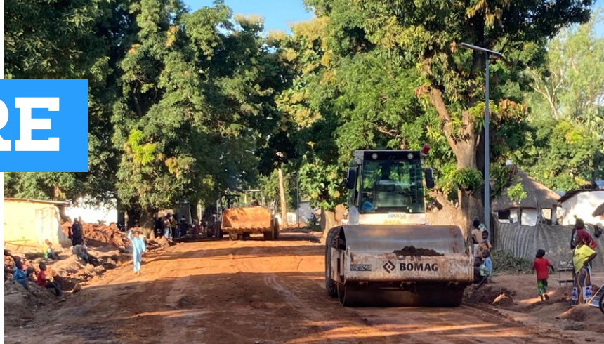
Réhabilitation des routes dans la ville de Kaga-Bandoro, par l'unité de Génie du contingent pakistanais
