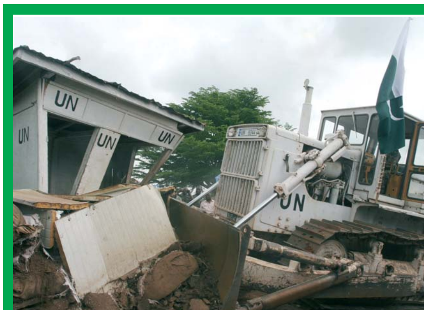
Démolition des portes d'observation de l'ONUCI dans l'ancien zone de confiance © UN / ONUCI
